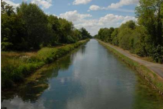
4- Le canal entre Matignicourt-Goncourt et Écriennes.
